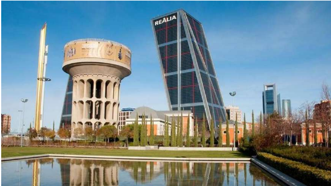
Plaza de castilla deposito elevado de hormigón del Canal de Isabel ii / Canal de Isabel ii
